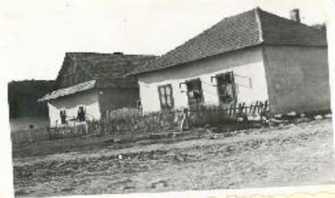
Stará škol. budova (1942)
