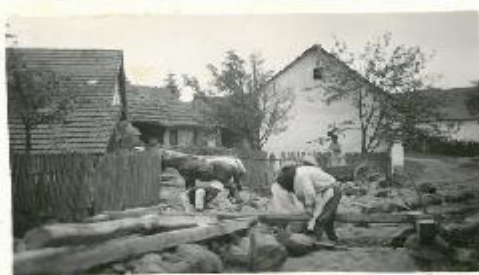
Oprava cesty v Kúte (1944)
