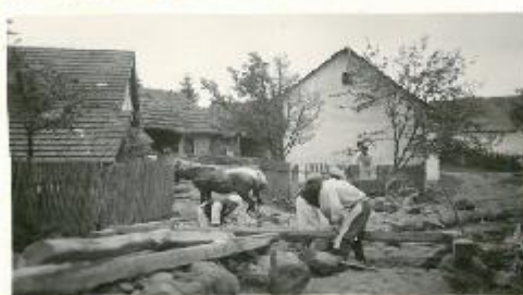
Oprava cesty v Kúte (1944)
